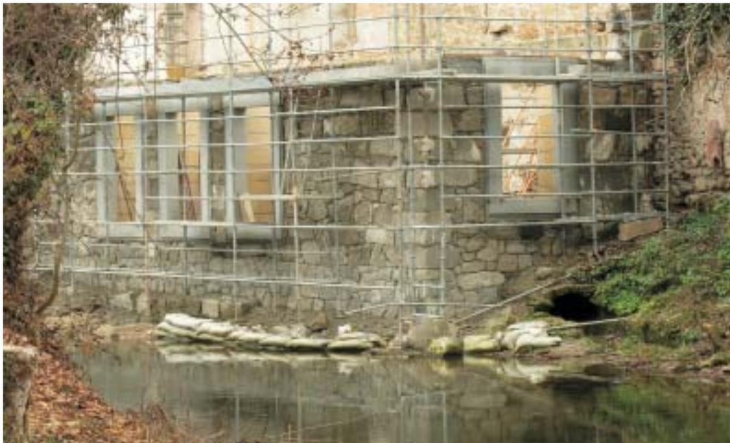
*Reconstrucción del extremo final del edificio herreriano. El muro exterior en esta parte del edificio se encontraba inclinado casi un metro debido a la erosión del río y las inundaciones que causaba el colector del barrio de San Marcos*
