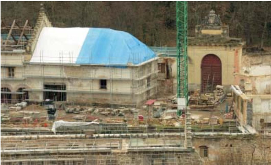
*Gran actividad en el patio alto de la Ceca, con el tejado de las bóvedas de la sala de fundición cubierto por un plástico*
