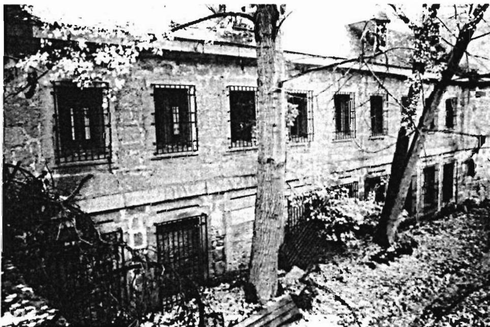
7b.—Las medidas de seguridad originales perduran todavía en el edificio del patio bajo: las rejas aún protegen las ventanas y una pared cortafuego resultó perfectamente eficaz en 1992 en un incendio provocado por el abandono del monumento (36).
